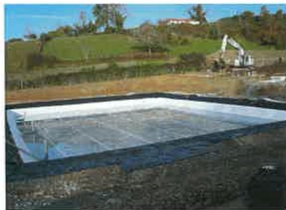
Puis une deuxième membrane géotextile. Vient alors le moment de la mise en eau pour tester l'étanchéité.
