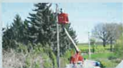
Axe Perreux à Notre Dame de Boisset longueur de fibre déployée : 2,8 km en aérien sur lignes électriques basse et moyenne tension
