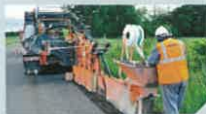
Axe Champdieu à Arthim longueur de fibre déployée : 22,8 km dont : • 6,4 km en aérien sur lignes électriques basse et moyenne tension • 9 km en souterrain (couverture de tranchées) • 7,4 km dans des ouvrages existants de France Télécom Orange
