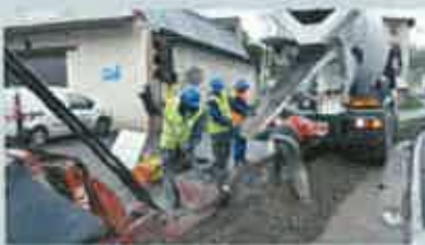
Axe Civens à Panissières longueur de fibre déployée : 11,6 km dont : • 9 km en aérien sur lignes électriques basse et moyenne tension • 2,6 km en souterrain (couverture de tranchées)
