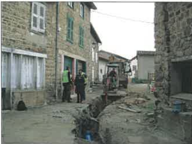
Reprise des réseaux d'assainissement et d'eaux pluviales avec déconnexions correspondantes.
