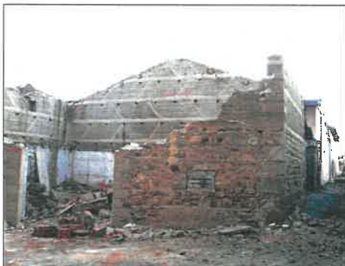
Pendant les travaux
