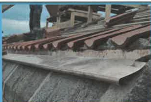
Détail du caniveau cuivre avec bavette d'habillage et ourlet formant goutte pendante
