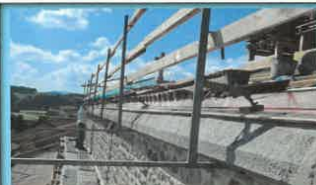
Pose des bavettes cuivre
