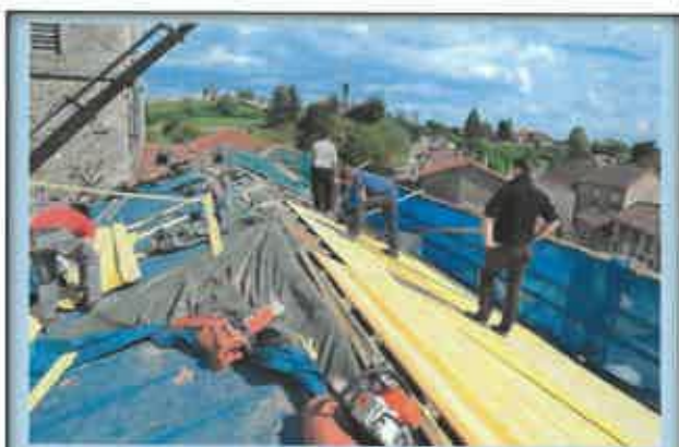
Pose de la volige sur le versant sud de la nef (partie ouest)
