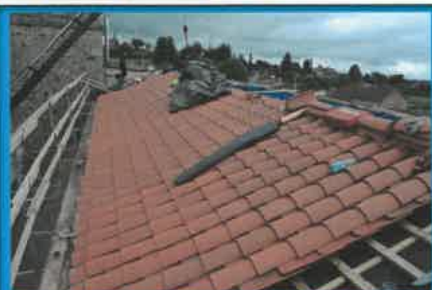
Versant nord de la nef en court de finition
