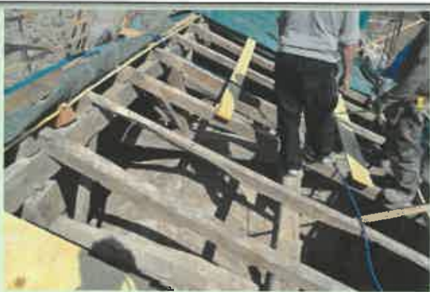
Versant sud : renforcement des entrails et fixation des sablières à l'avancement
