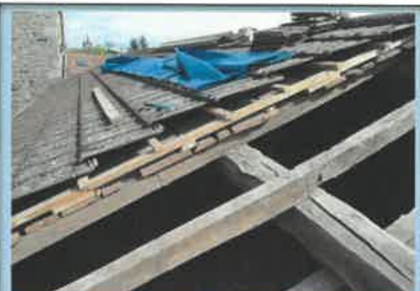
Dépose de la couverture et de la volige sur la partie ouest de la nef
