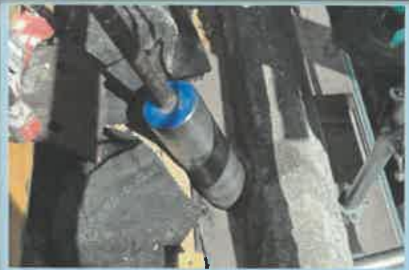
Carottage de la corniche pierre pour agrandir la naissance existante
