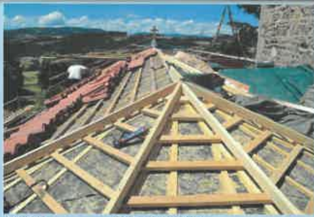
Abside : travaux préparatoires
