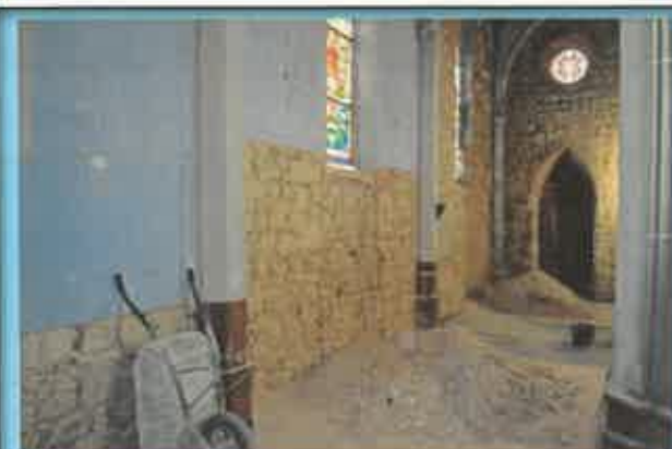
Piquages effectués dans le collatéral sud
