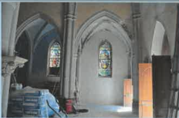
Élévation et voûte sur la 1 ère travée ouest après lissage de la couche de finition
