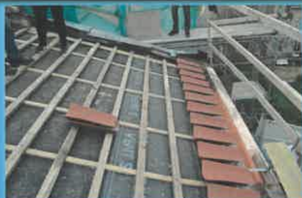
Scellement des tuiles d'égout en alignement au-dessus du caniveau cuivre
