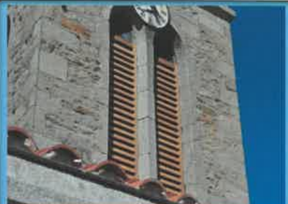
Remplacement des abat-sons à l'identique (4 sur 8)
