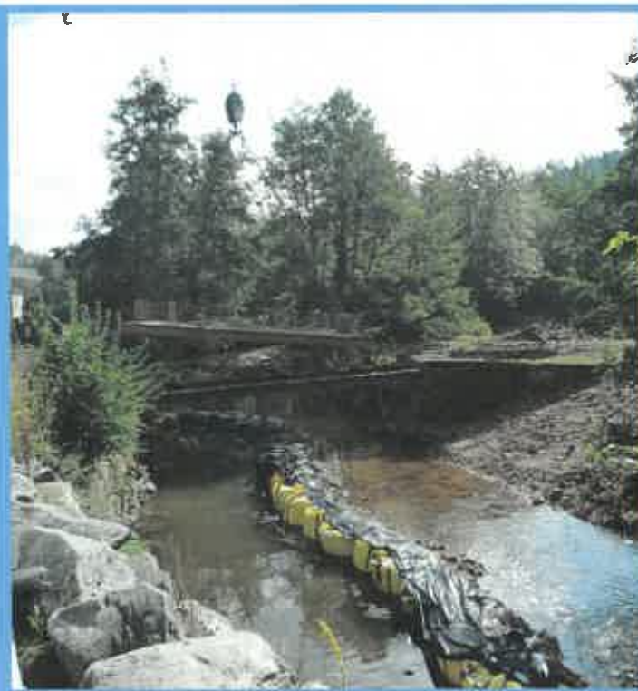
Réalisation d'un enrochement sur la rive grézollose
