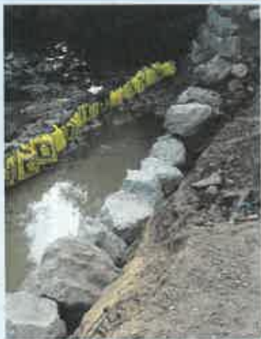
Réalisation d'un enrochement sur la rive grézollose
