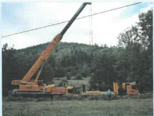
Un camion grue est approché.
