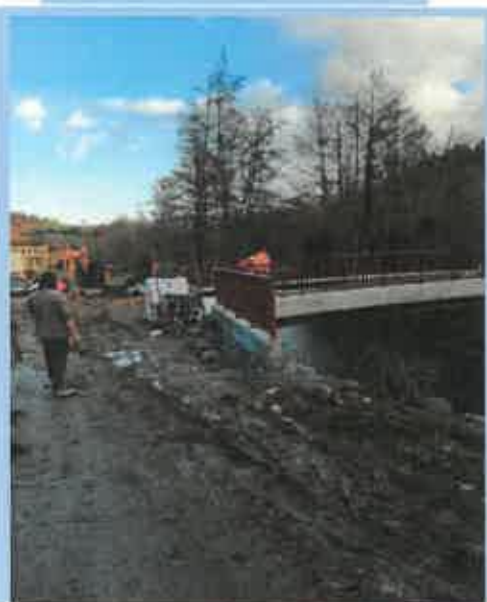
Pose des barrières et reprofilage des abords
