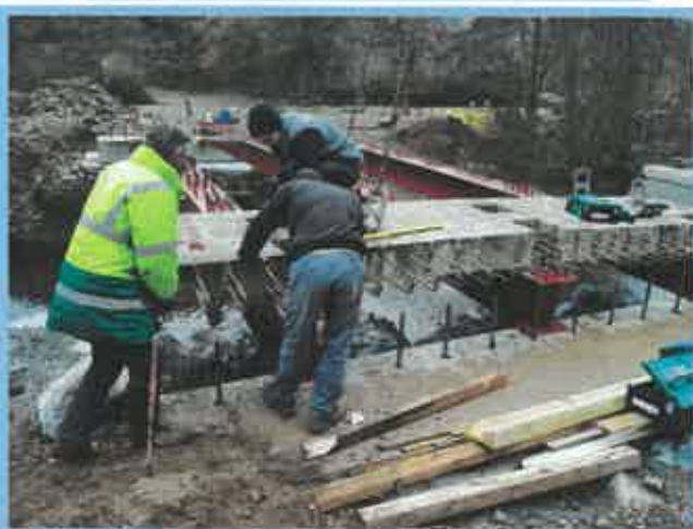
Pose du 1 er bloc préfabriqué
