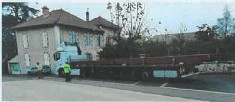
Livraison des poutres métalliques sur la place de l'église à Grézolles
