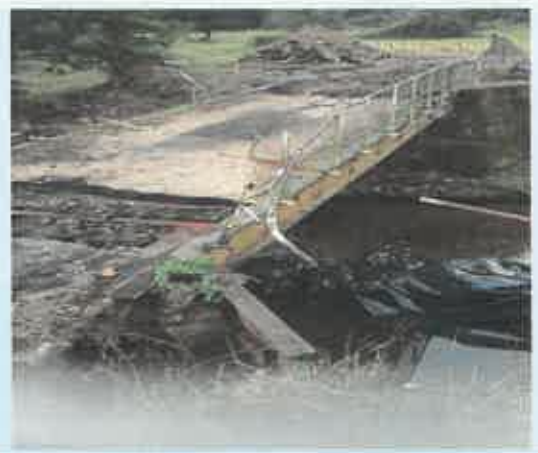
Quelques travaux de déconstruction
